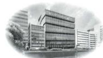
ヤマト港南ビル
