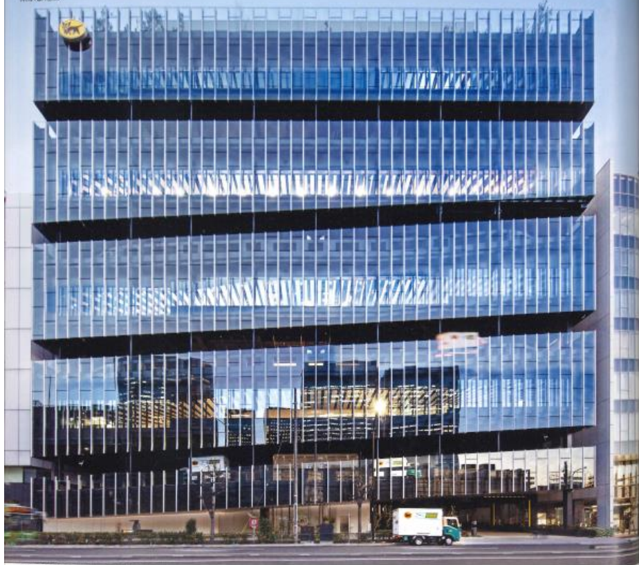
ヒトと車の領域が交互に突出するスパイラル状のファサード
