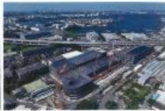
施工状況概観
