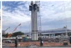
柱一体柱PCa搬付状況
