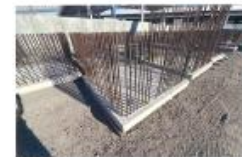
免震上部基礎下部PCa化
