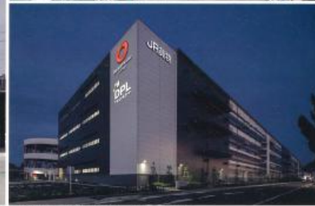
上ノ東側西側 左下ノ北西側外観夜景 右下ノエントランス
