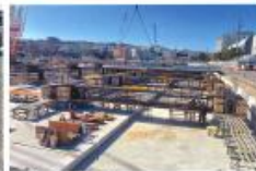
大梁配筋ユニット搬付
