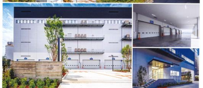
1F外観外観 5Fト/運搬機用出口 6Fト/ピロティ 6Fト/メインエントランス中
