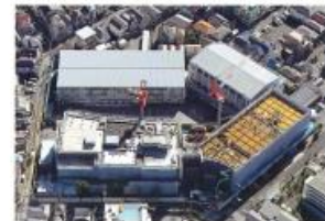
施工状況鳥瞰
