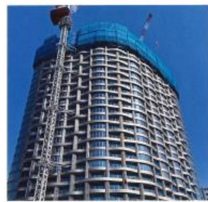
外装工事状況
