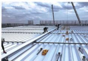
屋根葺き状況
