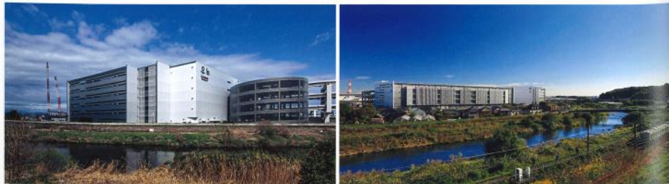
左/DPL新横浜I 南東側外観 右/DPL新横浜II 南西側外観 外観色を下層から上層にかけてグラデーションとし、空に抜けるようなイメージとしている
