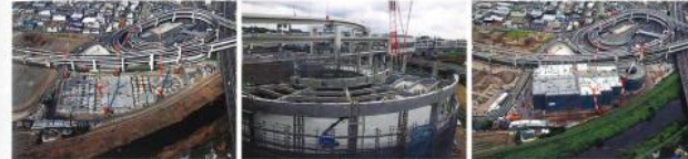
2021年1月 1階立上り躯体工事 2021年6月 ランプ橋PCaC建方状況 2021年8月末 6階立上り躯体工事
