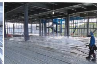
床の散水養生状況
