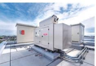
屋上設備スペース
