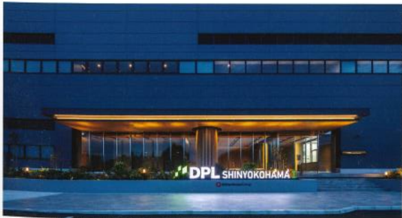
エントランス正面 キャンピアー上層はインテリアの素材と連続させ、内外の連続性を演出する
